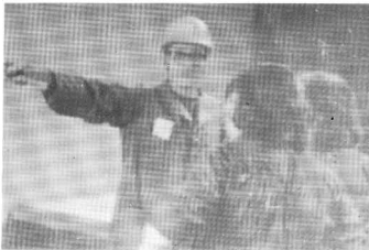
Mr. Shughart directs construction on mini mall. (Jack Veasey).
